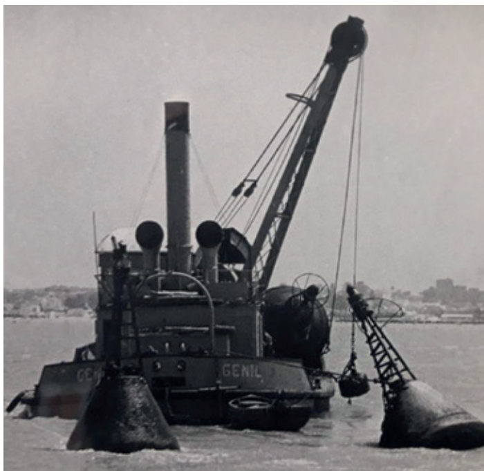
Imagen nº 3. Draga Genil colocando boyas en el canal de acceso a la broa o barra de Sanlúcar. Año s/f. Archivo de la Junta de Obras del Puerto de Sevilla.
