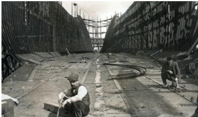
Figura 13.- Remachadores trabajando en el doble fondo de un buque
